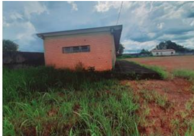
52 – Vista lateral vestiário
