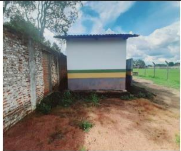
38 – Vista lateral do banheiro - reforma
