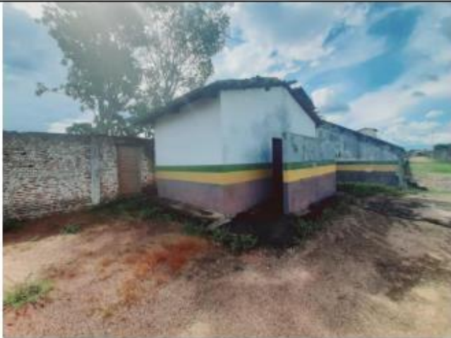
37 – Vista lateral/frontal do banheiro - reforma
