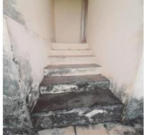
20 – Vista frontal degraus cabine de radio
