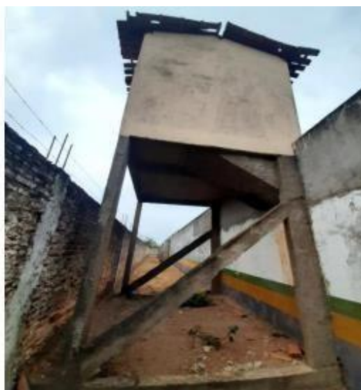
18 – Vista lateral cabine de radio
