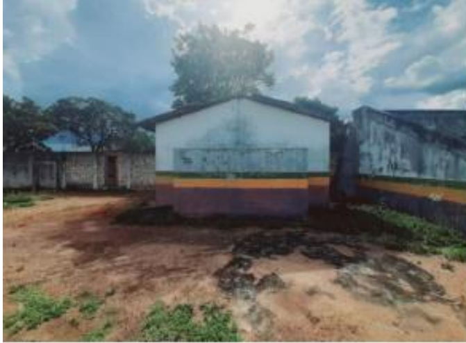
39 – Vista frontal do banheiro - reforma
