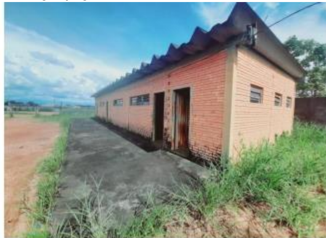
60 – Vista lateral/frontal vestiário
