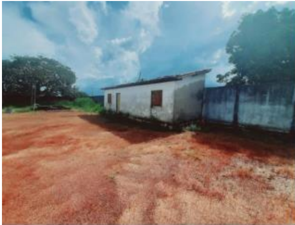
– Vista frontal galpão a demolida- vide declaração municipio
