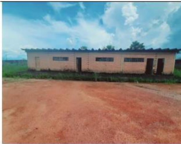
50 – Vista frontal do vestiário
