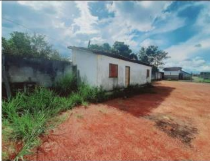
49 – Vista lateral galpão a demolida- vide declaração município
