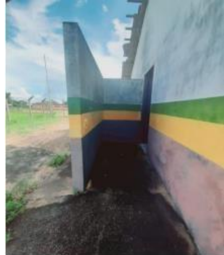
41 – Vista interna banheiro
