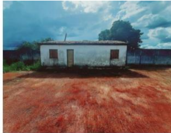
48 – Vista frontal galpão a demolida- vide declaração municipio
