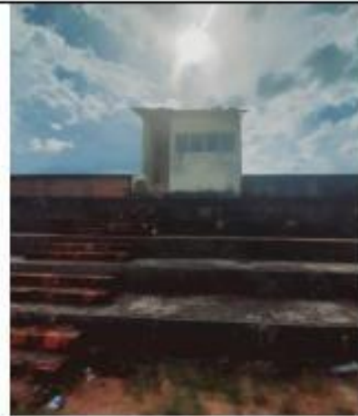
16 – Vista frontal arquibancada e escada, cabine
