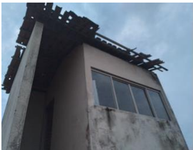
17 – Vista frontal cabine de radio
