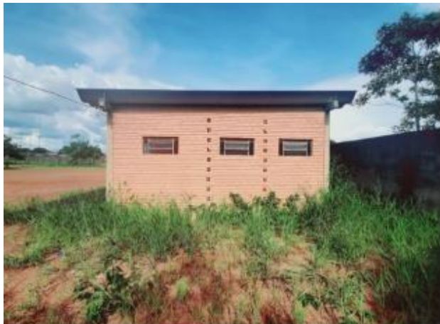
59 – Vista lateral vestiário
